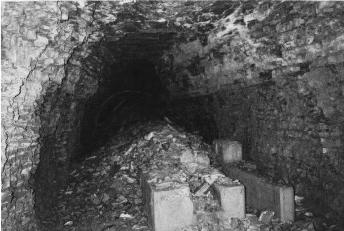
Fundamente für eine Lüftungsmaschine (KZ- Gedenkstätte Vaihingen/Enz)
