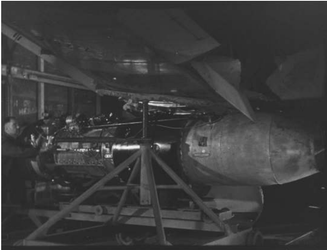
Takt 2b, Einhängen des Triebwerks (Waffen, Hände, Herzen, BArch-FA BSL 24347-2)
